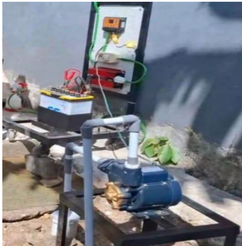
Gambar 6 Instalasi Pompa Air Tenaga Surya
